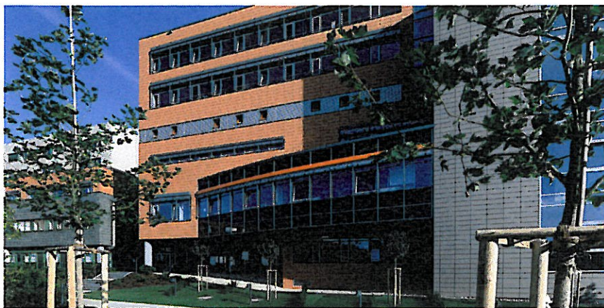
Neubau der SHG-Kliniken Völklingen. Hier sind die wichtigsten Funktionsräume für die Sektion Gefäßchirurgie untergebracht.
